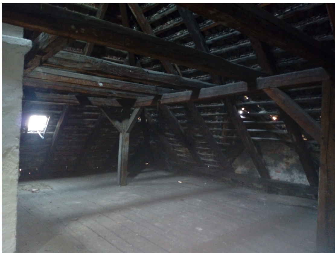
Zdj. 2 Nieszczelność pokrycia dachowego i miejscowe uszkodzenia podłogi na strychu.
